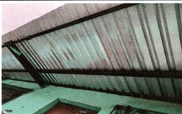
Foto 3: Cubierta de Laminas para dos salones del Centro Educativo
