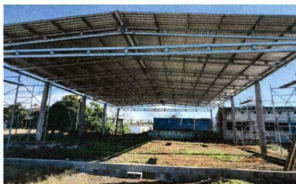
Foto 2: Estructura de techo para el mejoramiento del salon de usos multiples del Centro Educativo
